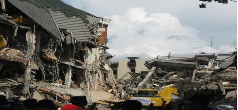
Foto: Sebuah bangunan remuk dan luluh lantah tak berwujud di kota Padang akibat gempa bumi 30 September 2009
